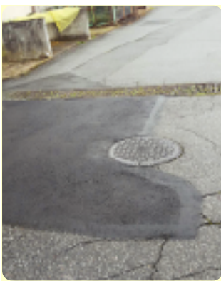
平らになった修繕後の道路
